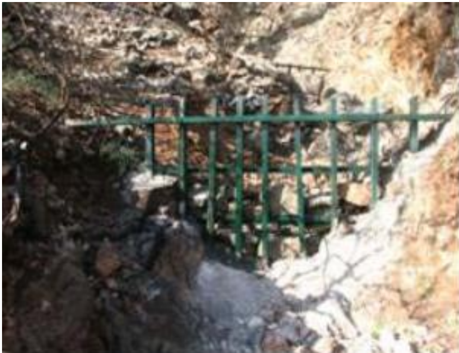
Πιλοτική μεταλλική κατασκευή φράγματος κατακράτησης φερτών υλικών στο χείμαρο «Εκκλησία» στην Φιγαλεία Ηλείας (Πηγή: Π. Στεφανίδης κ.α. 2012).
