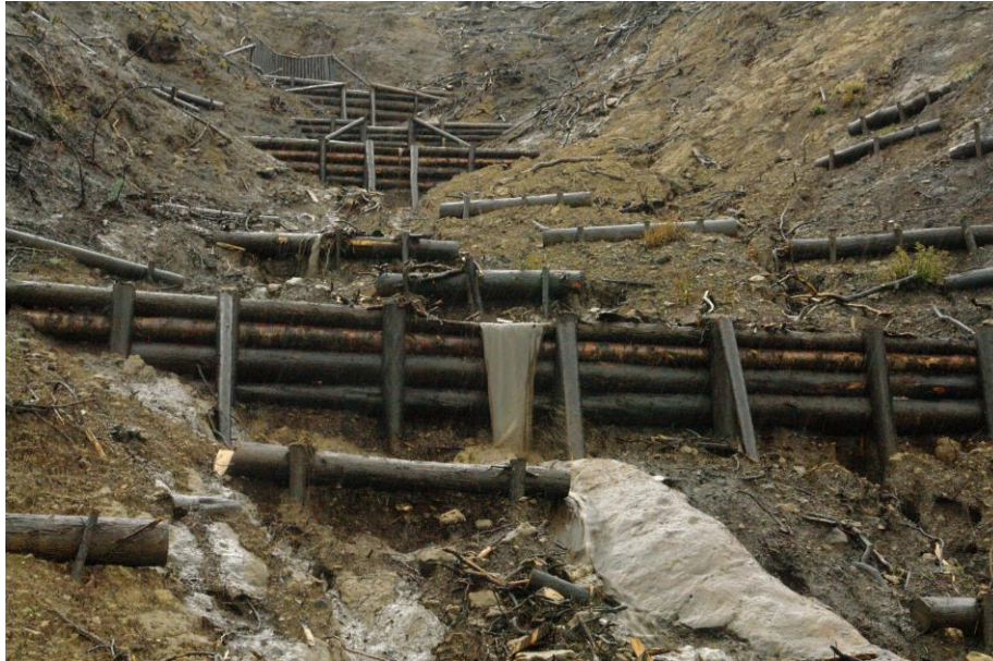
Σειρά κορμοφραγμάτων στον Κρόνιο λόφο της Ολυμπίας μετά την καταστρεπτική πυρκαγιά του έτους 2007
