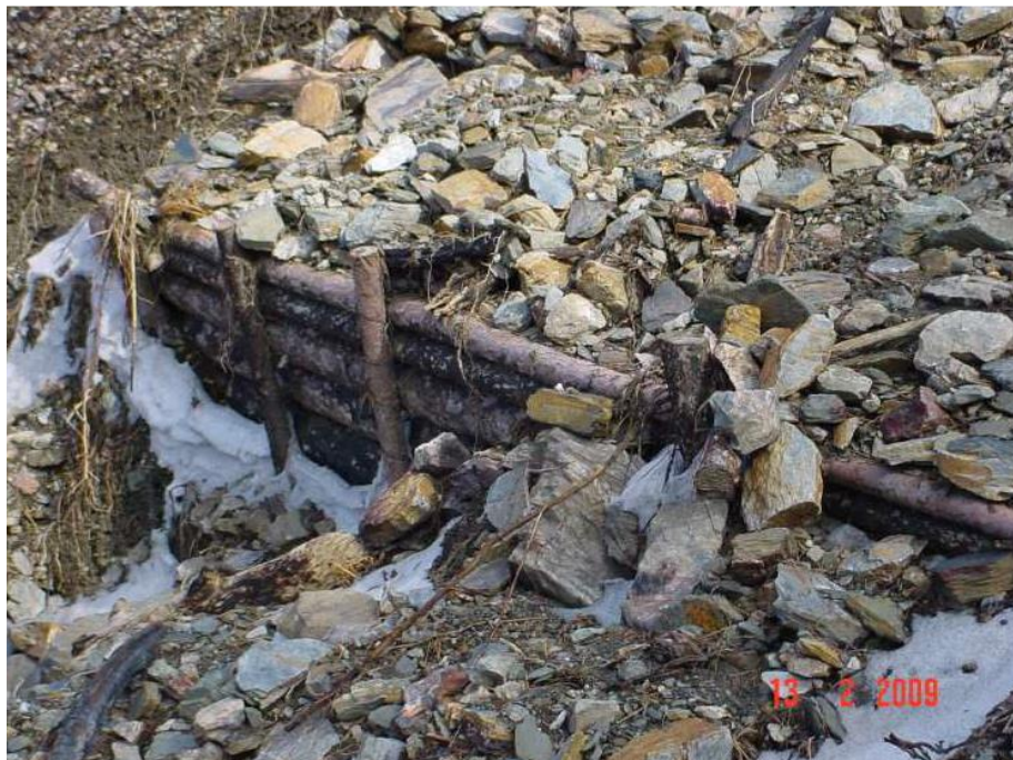
Κατακράτηση φερτών υλικών από κορμόφραγμα στο δασικό σύμπλεγμα Ταυγέτου, μετά από δεκαετία από την κατασκευή του
